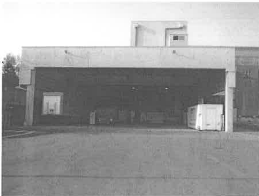
Figura 15. Capannone per il deposito preliminare dei rifiuti speciali (sanitari e ospedalieri) pericolosi e non pericolosi.
